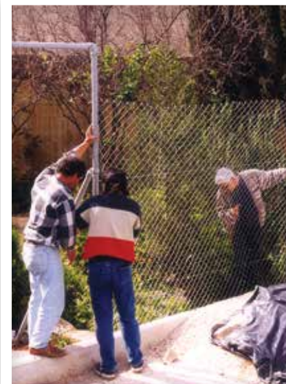
Εγκατάσταση συρμάτινου φράχτη κατά μήκος των κύριων συνόρων για να μειωθούν οι ζημιές από άστοχες μπαλιές
