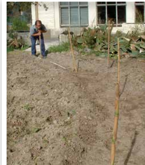
Το μονοπάτι της φύσης αποτέλεσε την πρώτη φάση του έργου, εδώ ήδη σκαμμένο και οριοθετημένο για την προετοιμασία της στρώσης αδρανών υλικών
