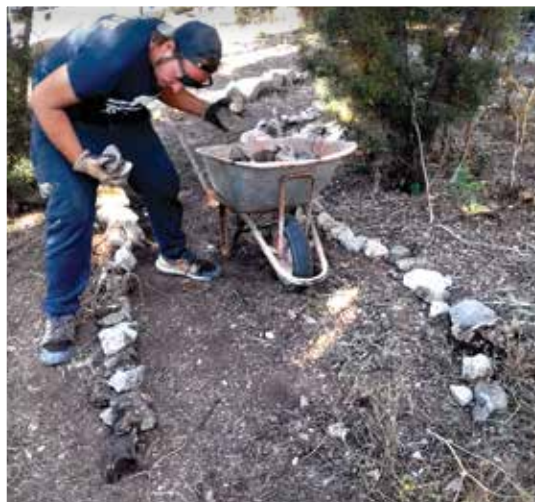
Επένδυση του μονοπατιού της φύσης με πέτρες
