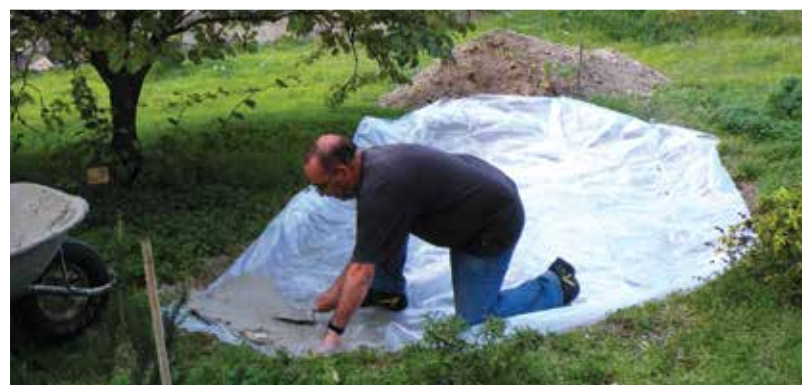
Κατασκευή της λίμνης γλυκού νερού σε εξέλιξη - εκτός από την επένδυση πολυαιθυλενίου, η λίμνη αυτή έλαβε επίσης βάση από τσιμέντο
